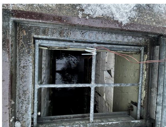
図5 水温・躯体温度を計測する際の熱電対の位置（北側流雪溝）
