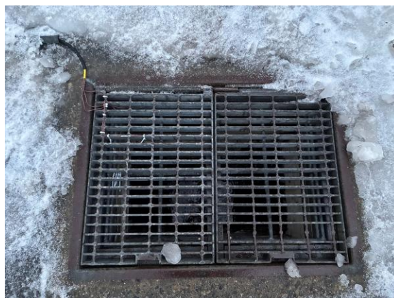
図4 表面温度を計測する際の熱電対の位置（南側流雪溝）
