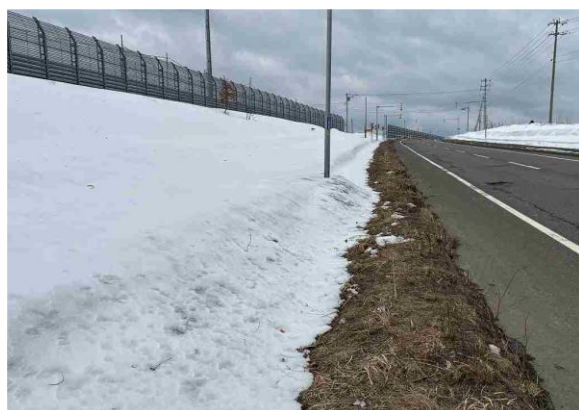
図 6 図 5 の A 地点. 小さい防雪容量を法肩の吹き止め柵で補っている。
