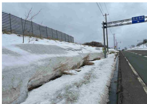
図 7 図 5 の B 地点. 小さい防雪容量を法肩の吹きだめ柵で補っている。
