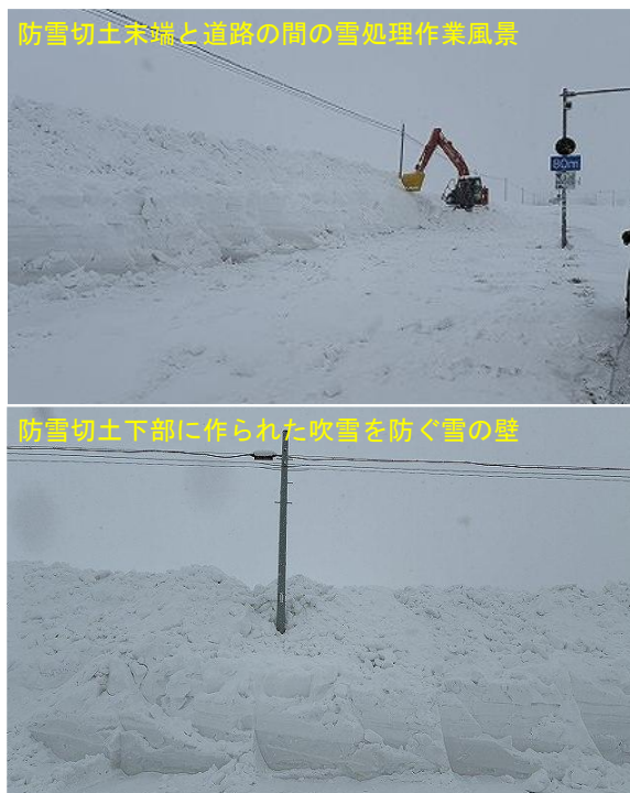
図 8 図 5 の C 地点. 切土末端と道路の間の雪で雪の壁を作り、道路への吹き込みを防ぐ。
